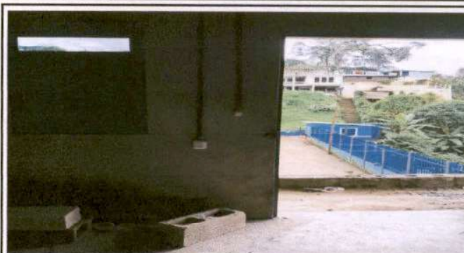
Foto 2: Colocación de piso e instalación de energía eléctrica
