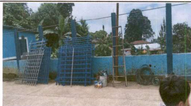
Foto1: Colocación de portón
