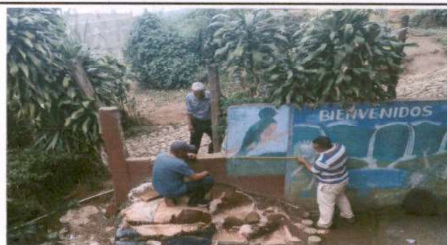
Foto 4: Circulación y colocación de portón
