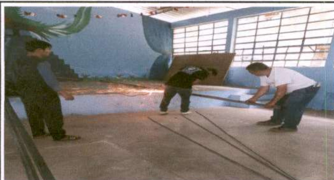
Foto 3: Colocación de balcones
