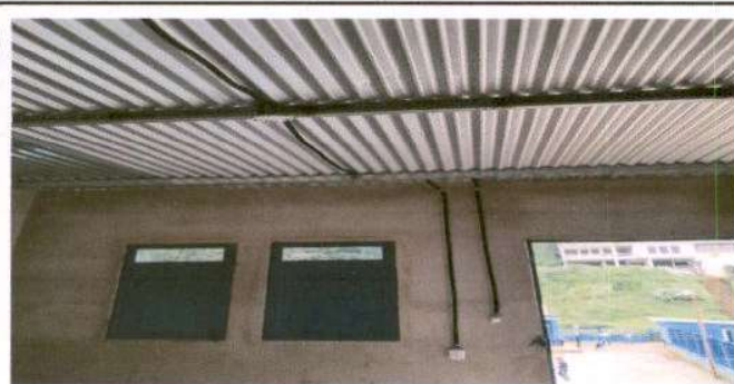
Foto 5: Colocación de puerta y ventana, circulación con maya y tubos galvanizados.
