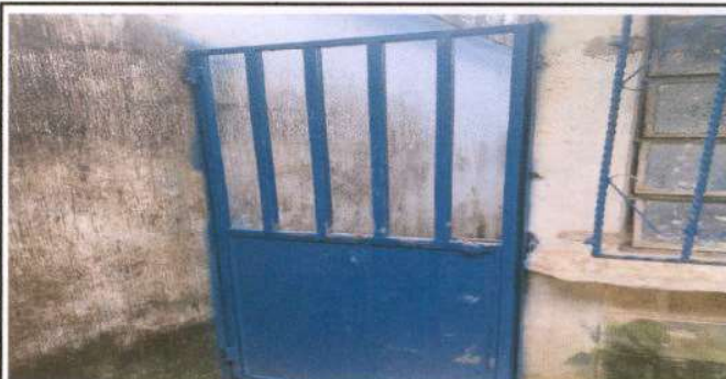
Foto 6: Colocación de Portón
